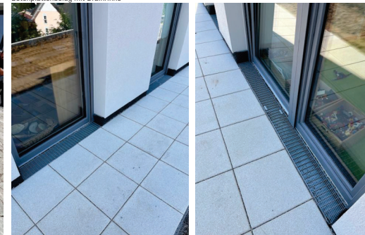
Betonplattenbelag mit Drainrinne
